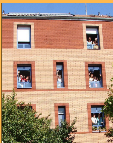
Logements SNL à Saint-Maur
